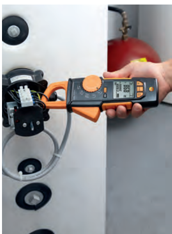
Měření napětí na tepelném zásobníku přístrojem testo 770.
