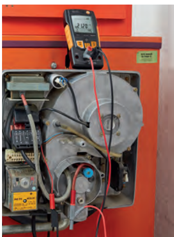
Měření ionizačního proudu s testo 760.
